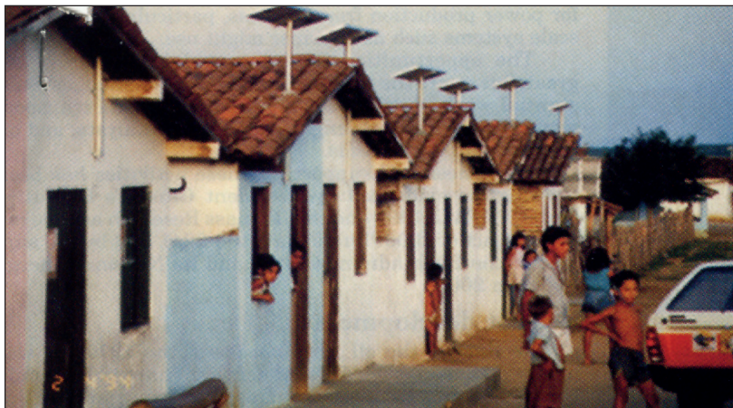
Είκ. 12: Μικρά φωτοβολταϊκά παράγουν ηλεκτρική ενέργεια για φωτισμό σε ένα απομακρυσμένο χωριό της Βραζιλίας («Έξυπνα Χωριά» – «Smart Villages») [56].
